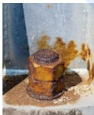
**6.3. Atmosferik Korozyon:** Bu korozyon tipi isi ve yüksek nem, kukurt dioksit veya klorurlar gibi çevresel degisenlerin yarattığı korozyonu ifade eder. **Atmosferik korozyon genellikle yalnızca metalin yüzeyinde bir nem filmi mevcut olduğunda meydana gelir.** Yuksek isi ve nem olmadığında, cogu kirletici çok az veya hiç korozyon yaratmaz.
